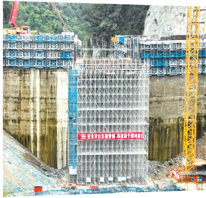
塘坎上水库建设现场。 本报记者 卢泰铭 摄
