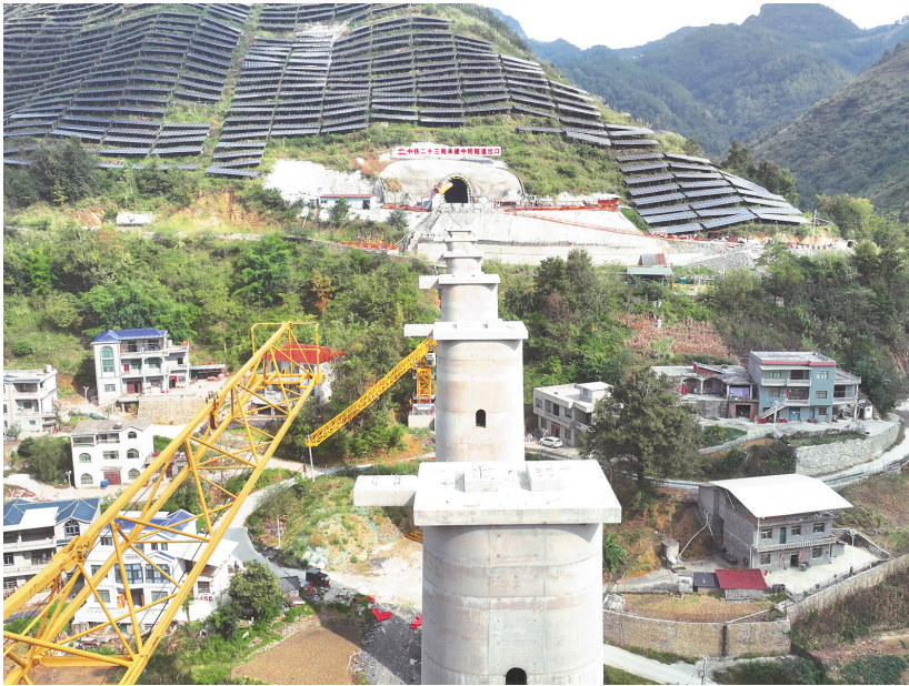
中铁二十三局承建的黄百铁路贵州段交洞大桥工地。秦渔歆 摄
