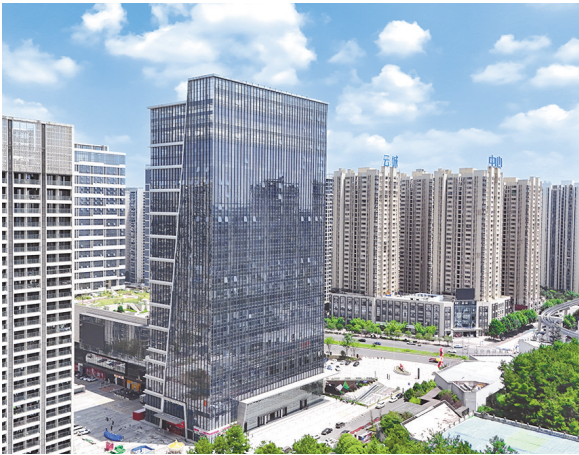
贵州海鹰数字医疗器械产业园。
