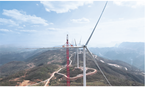
沿河自治县晓景乡苦竹村风力发电项目。
