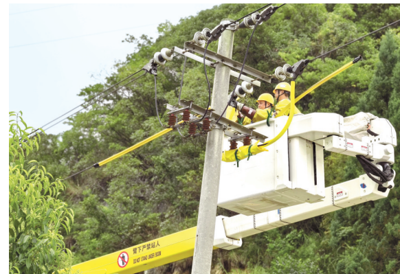
工作人员带电检修线路。
