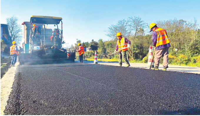
施工人员铺设沥青。 唐丹 摄
