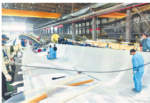
贵州珂立复合材料科技有限公司工人对生产的风电叶片进行铺层作业。贵州日报天眼新闻记者 高荣华 摄
