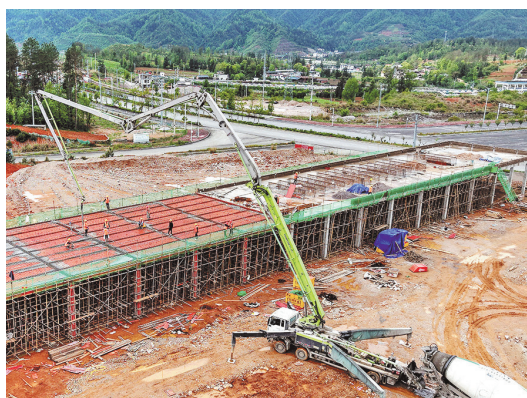
风氢氢能（贵州都匀基地）绿氢零碳智慧园综合动力站房施工现场。李航 摄
