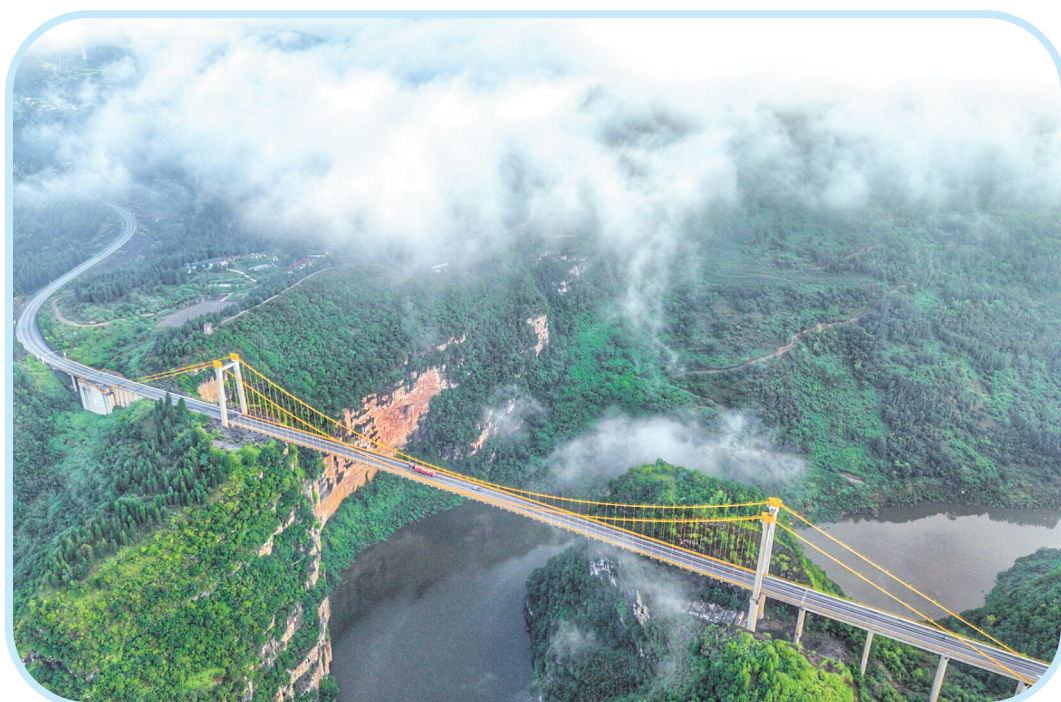
G321线西溪特大桥。 卢昌跃 摄
