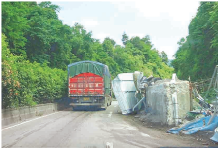
沿线围挡钢筋裸露，损坏铁皮伸向车行道。
