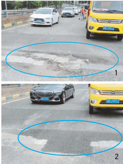
图1、图2为海信立交桥道路问题修复前后。
