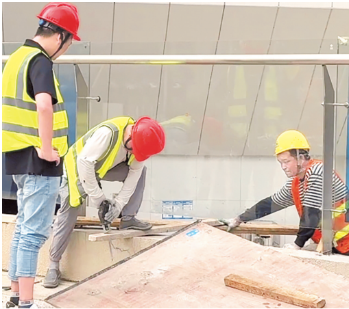
新玻璃安装后进行固定。取下，将新玻璃进行固定，并灌注专用
