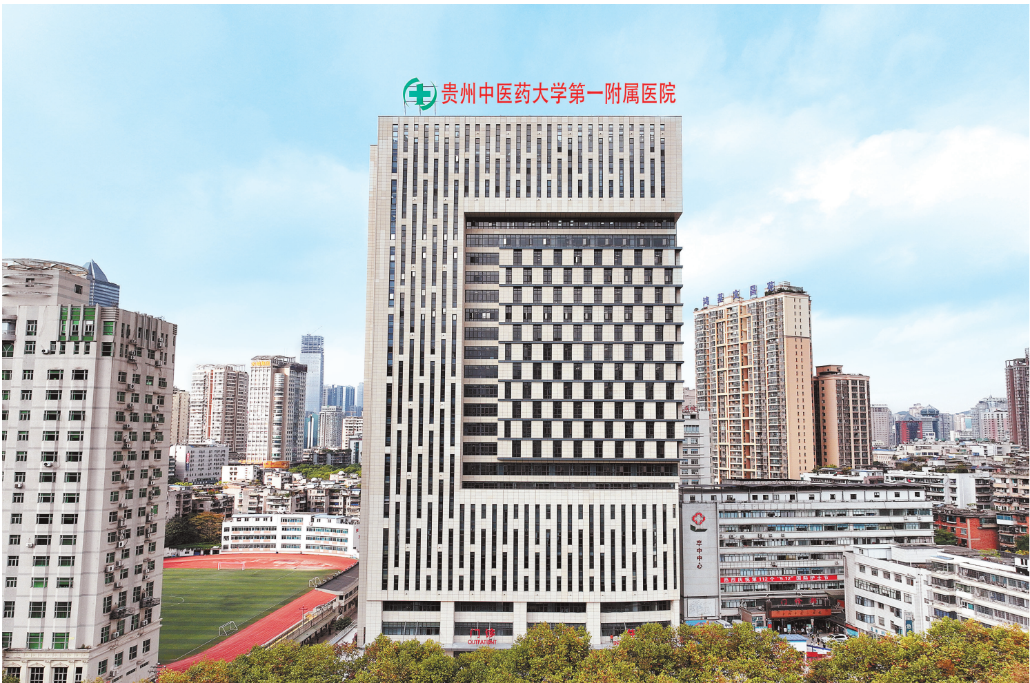
医技住院综合楼。
