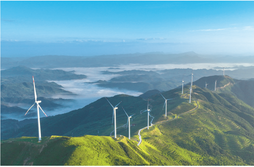
铜仁市石阡县石固乡云海翻涌间的大顶山风电场。 申逸恺 摄（影像贵州）
