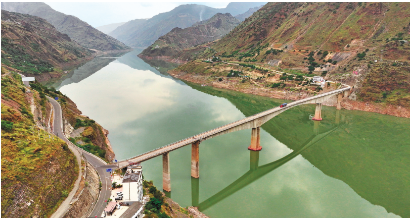
金沙江上,新皎平渡大桥连通两岸。 本报记者 汪国锋 摄
