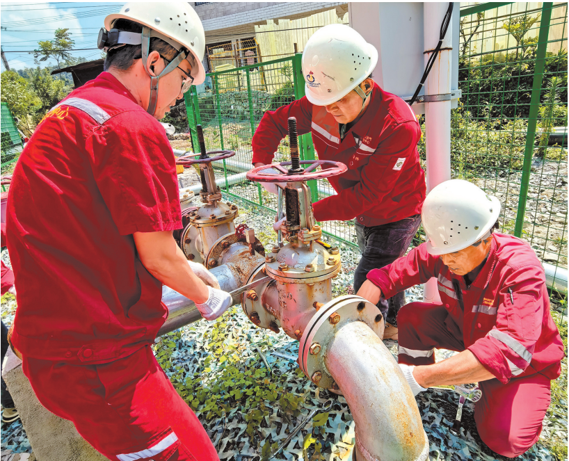
毕节市织金县肥田煤矿地面卸压井井场，运维人员正在对井口阀门、输送管路开展检修维护作业。（受访者供图）
