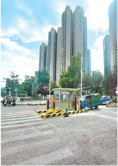
↑ 樱花大道路口（富源中路侧）安装的停车收费系统。 → 樱花大道中段安装的道闸、U形挡车杆及路边规划的停车位。
