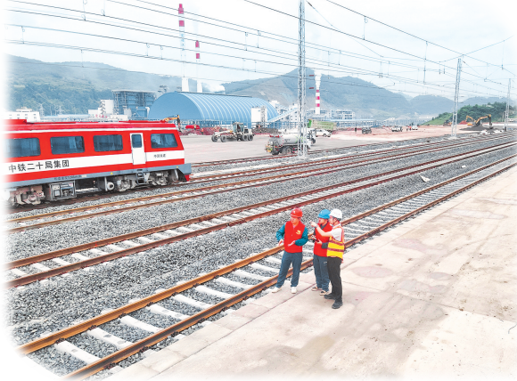
南方电网贵州都匀瓮安供电局工作人员在瓮马铁路进行电力巡检。
