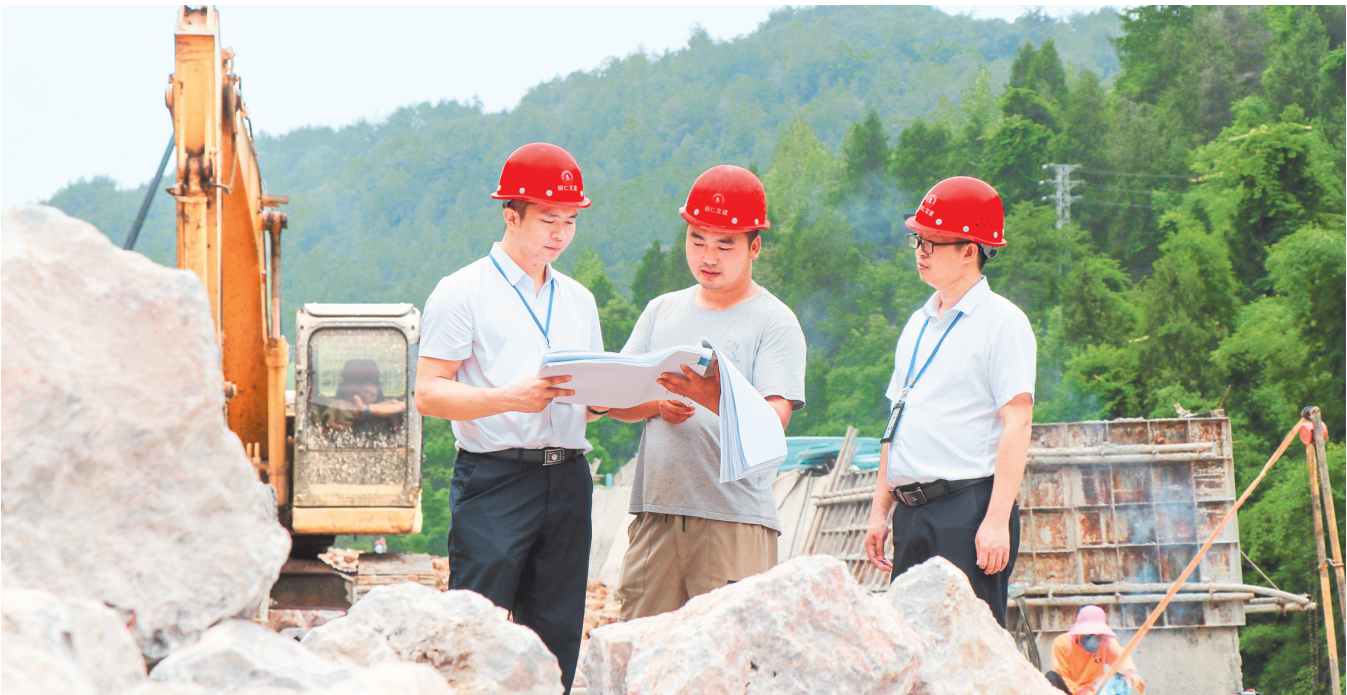
铜仁市松桃自治县纪委监委在孟溪镇公路改扩建工程项目建设现场开展监督，确保项目建设廉洁高效。 王润 摄
