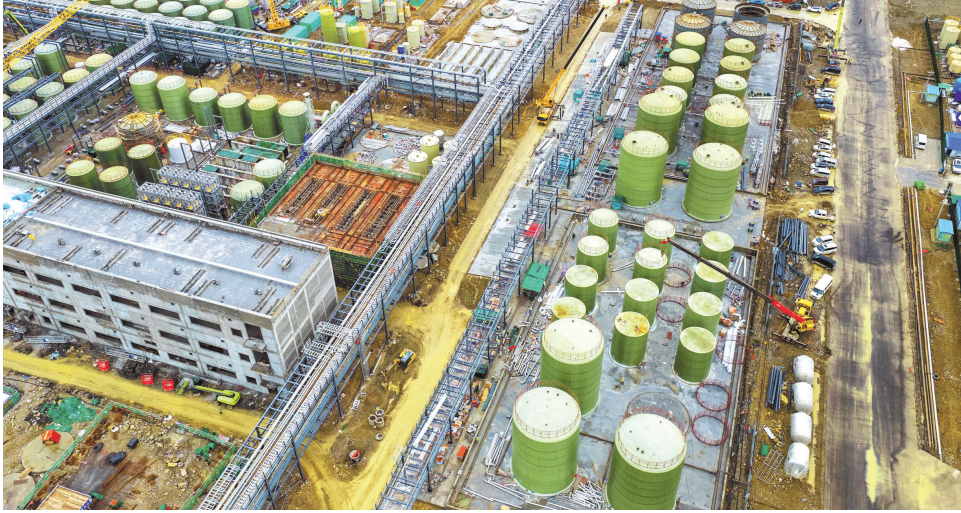
建设中的毕节磷煤化工一体化项目。
