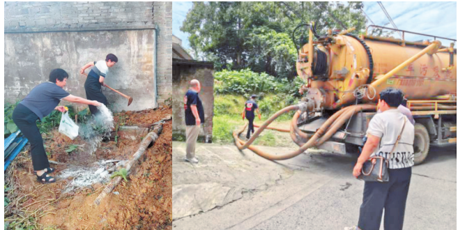
左图：回填泥土并消毒处置。右图：抽取清运化粪池污水。
