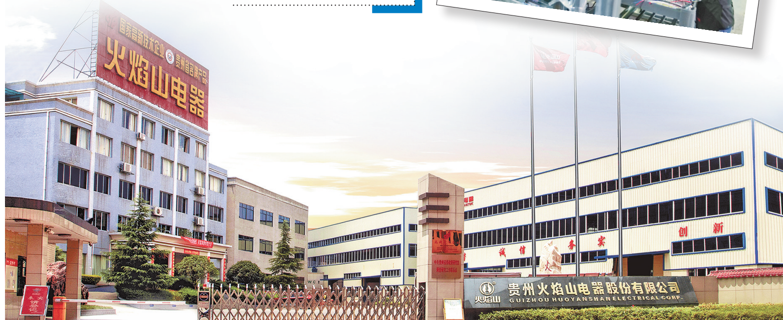
贵州火焰山电器股份有限公司。
