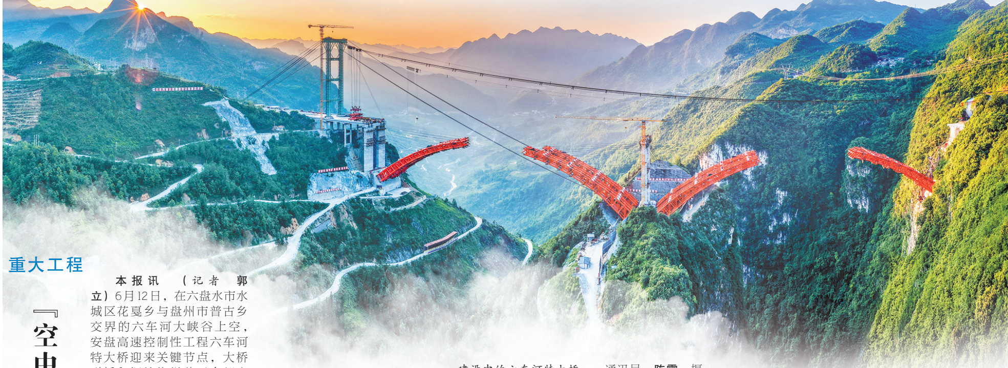
建设中的六车河特大桥。 通讯员 陈露 摄
