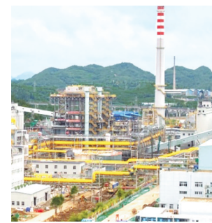
在建的水城区煤—焦—化—电循环经济基地项目。
