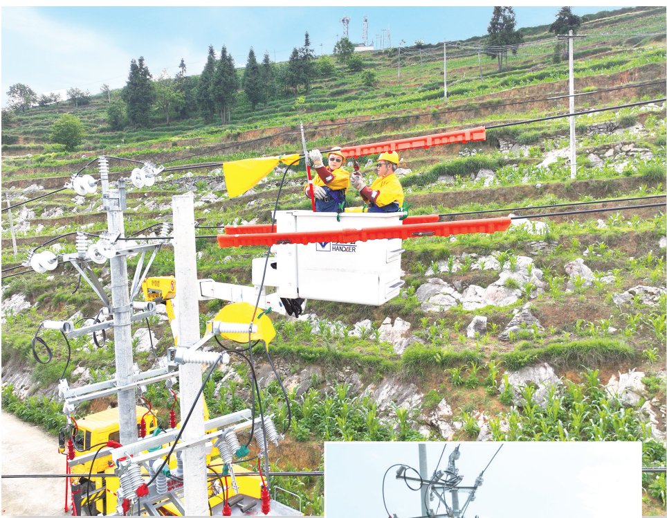
↑工作人员采用带电作业法对新型配电网一二次融合自动化进行搭火。吴春艳 摄
