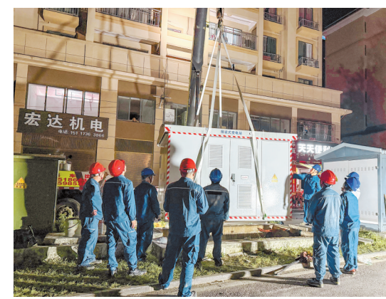
10千伏纳高线更换预装式箱式变电站吊装。
