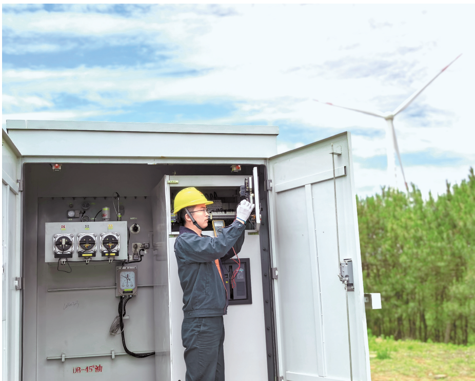
贵州龙源新能源有限公司工作人员对箱式变压器进行数据监测与研判。
