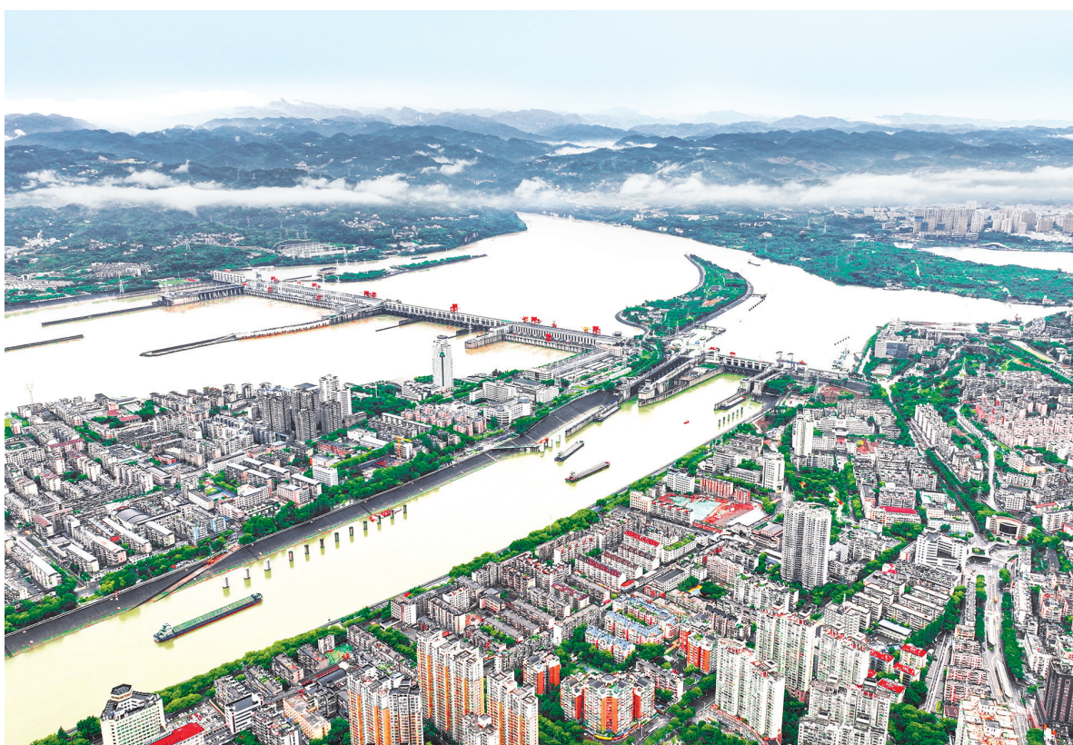
三峡水运新通道工程葛洲坝航运扩能施工现场。
