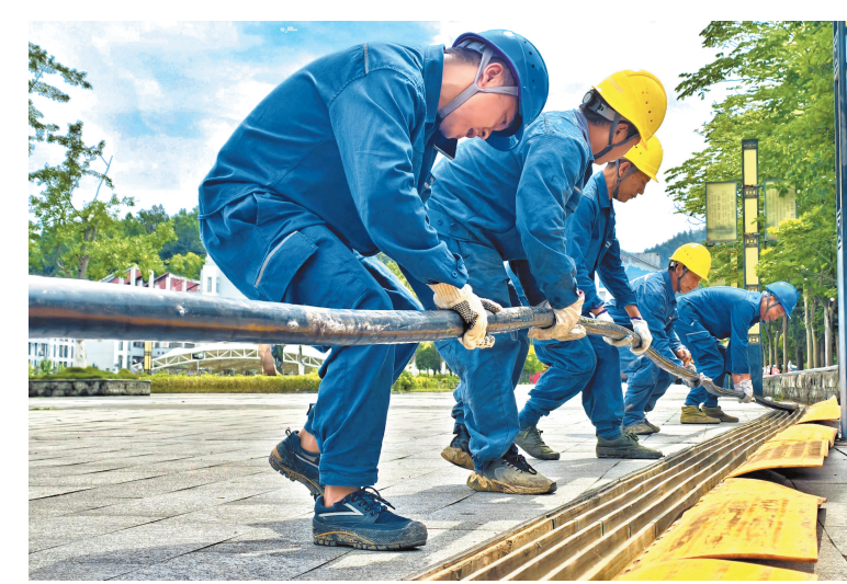
遵义供电局工作人员在检修线路。
