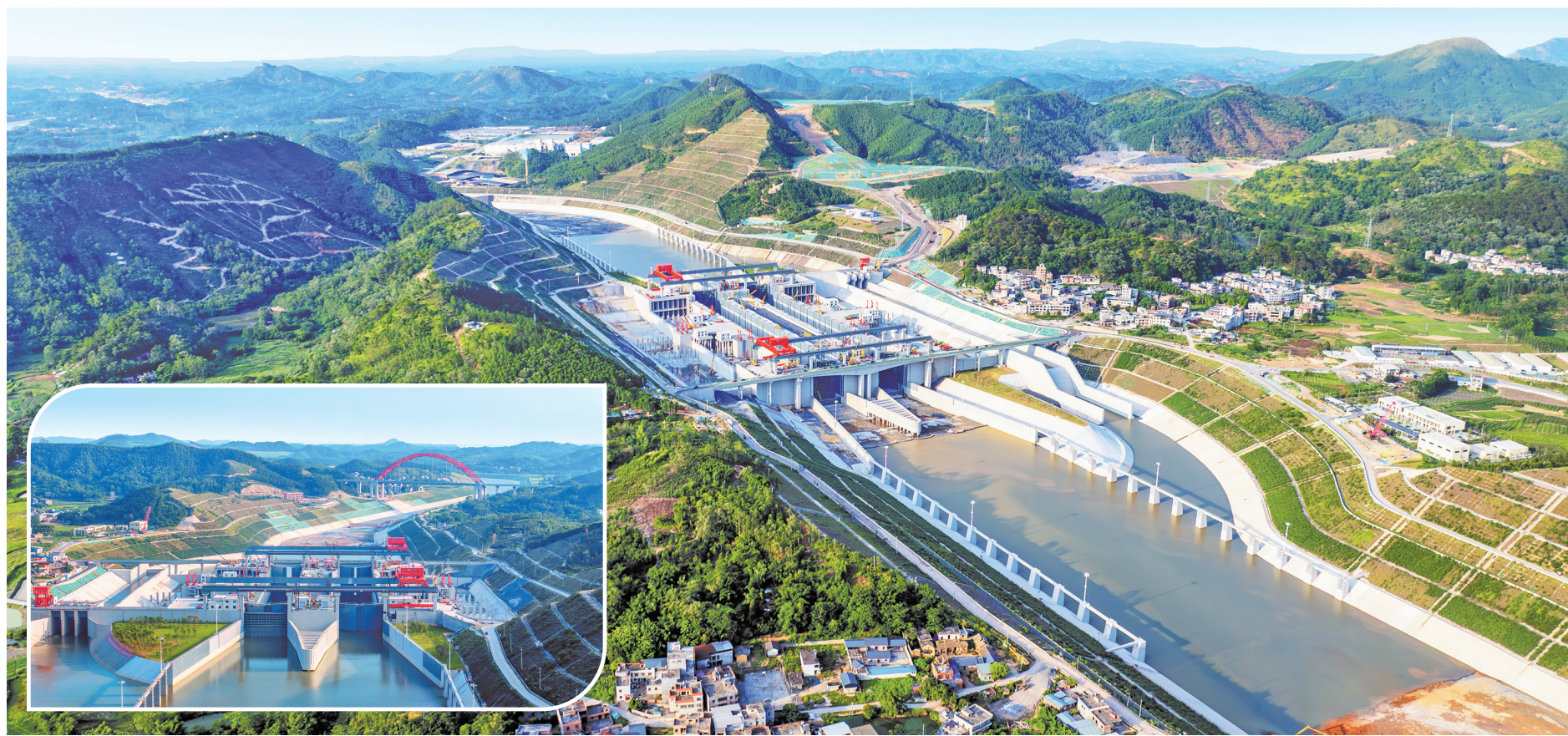
6月3日广西平陆运河马道枢纽充水现场。新华社发
