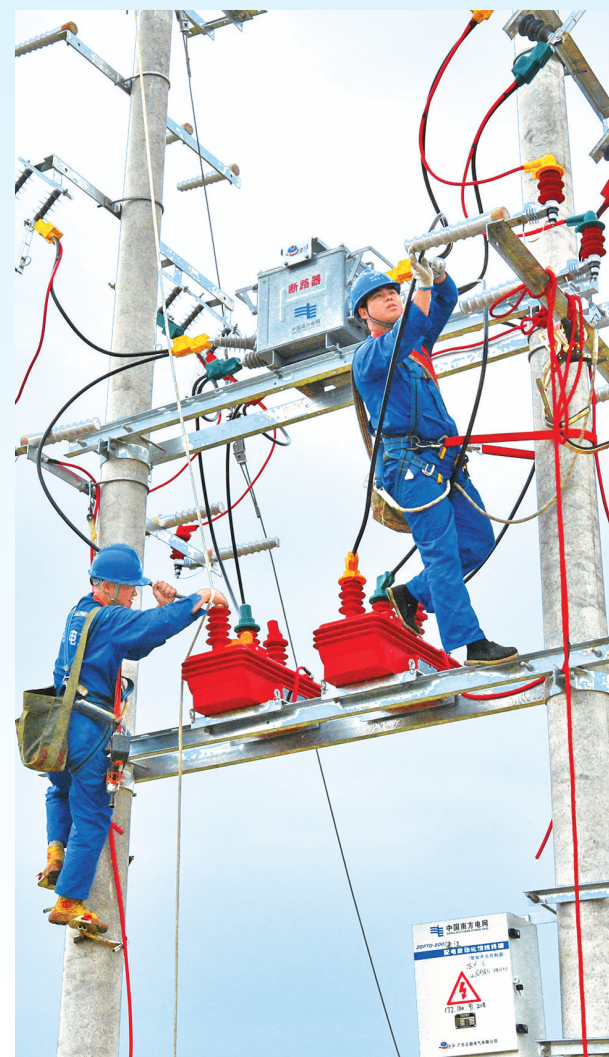
南方电网贵州铜仁德江供电局工作人员在10千伏德桶线46号杆上安装断路器。
