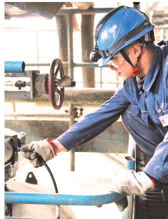
华电乌江公司塘寨分公司维护人员更换除尘落料阀。
