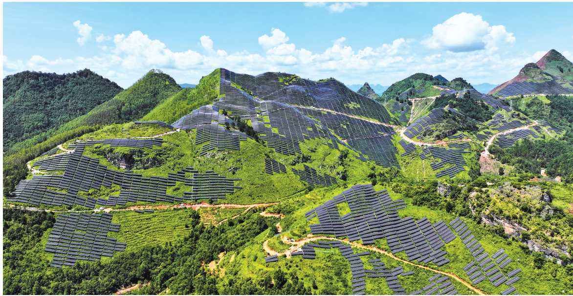
黔南州罗甸纳尼光伏项目。
