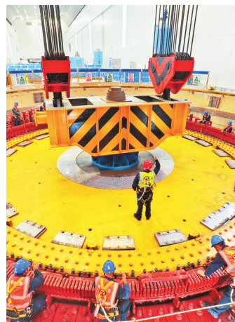
索风管发电厂开展1号机组A修。
