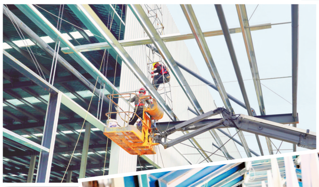
↑贵州焯峰酿造科技有限责任公司项目建设的生产线上，工人进行外墙封板工作。
