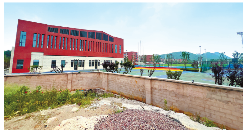
建设中的贵州希望学校。
