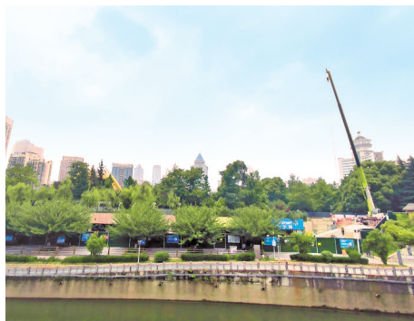
改造工程地面施工。
