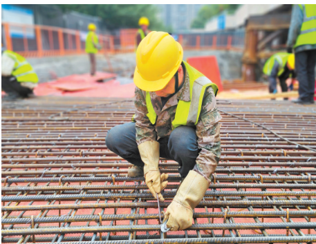
五连通道顶板钢筋捆扎。
