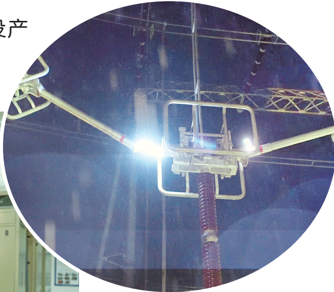
↑在兴安直流兴安换流站，控制保护系统改造项目复电操作台上隔离开关时弧光照亮夜空。王凯 摄
