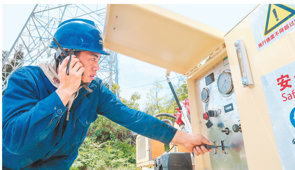
在输电线路迁改工程施工现场，贵阳供电局工作人员规范操作设备，保障施工安全，提升施工效率。 杨志坚 摄
