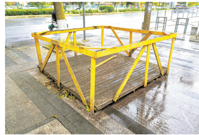
木框下面是电缆井。
