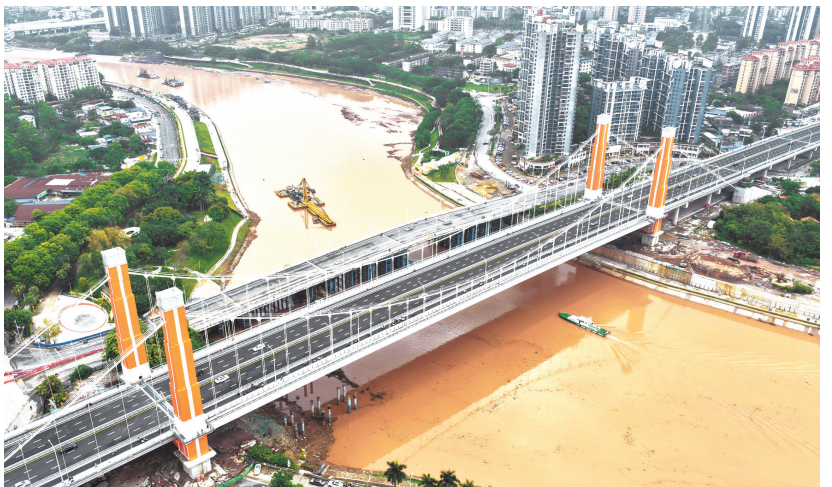
4月28日，平陆运河关键跨河通道子材大桥正式通车，标志着平陆运河规划的27座跨运河桥梁全部建成。图为4月28日拍摄的建成通车的平陆运河子材大桥。新华社记者 周华 摄
