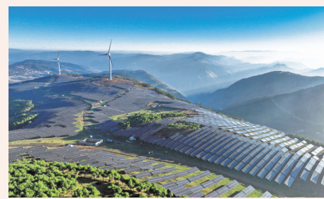
毕节市威宁自治县海拉镇平箐风能光伏电站项目，风力发电机组和太阳能光伏板相映生辉。胡攀学 摄（影像贵州）
