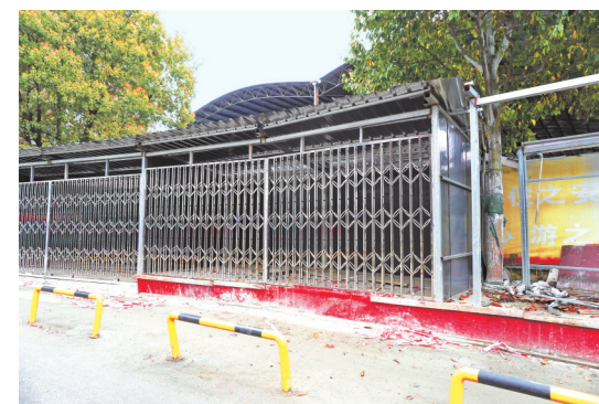
绿化带被铲除，门面的钢结构已基本搭建成型。
