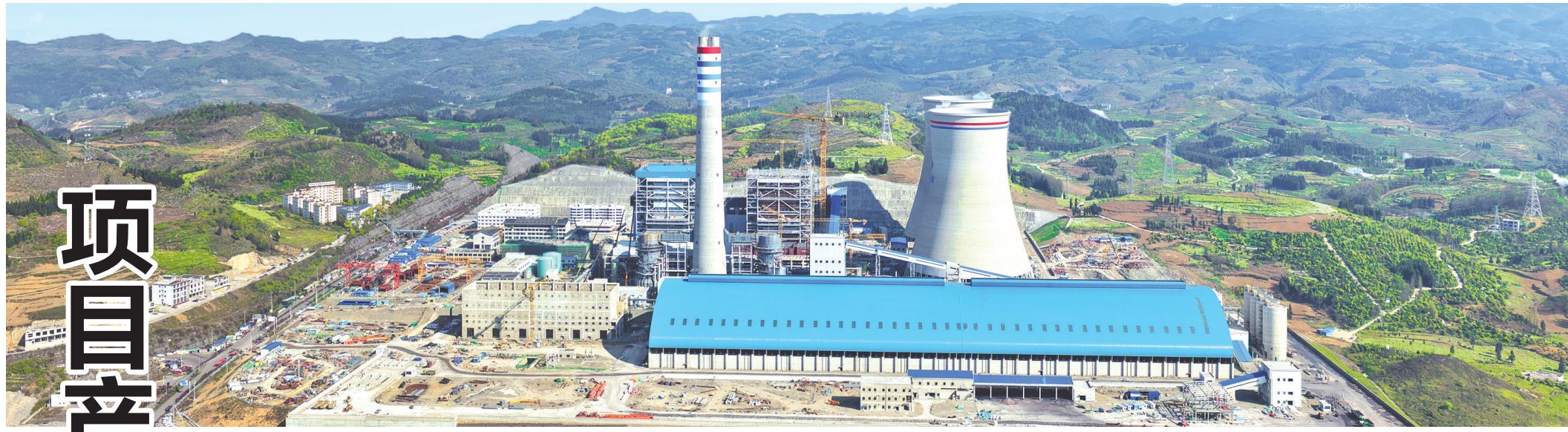
盘南2×660MW低热值煤资源综合利用发电项目。(受访者供图)
