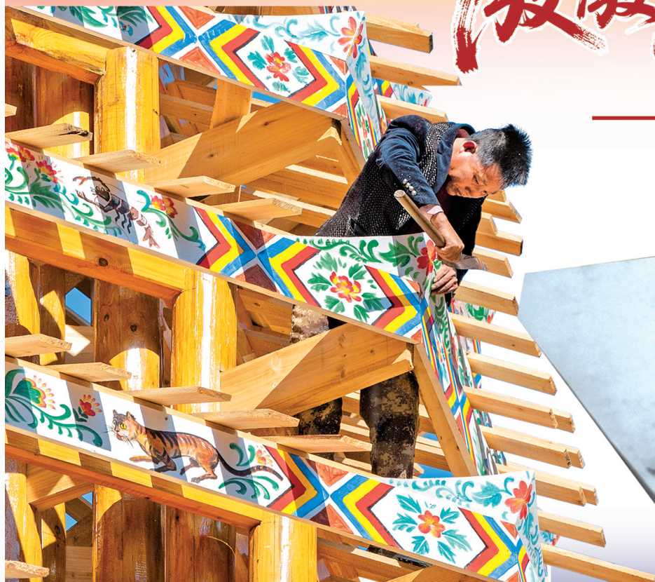
工匠在黔东南州从江县高增乡美德村修建鼓楼。 罗京来 摄（影像贵州）
