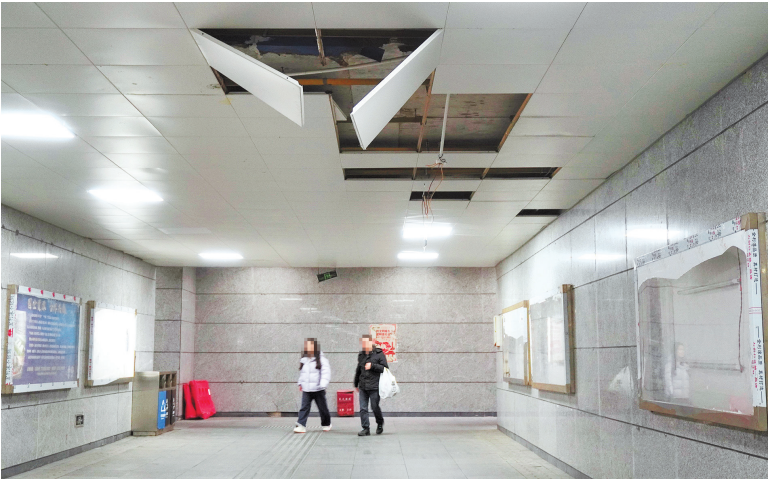
吊顶板脱离龙骨，摇摇欲坠。
