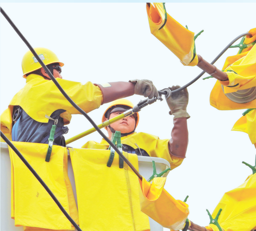
←↑实施带电作业对10千伏架空配电线路进行入地改造。 卢关文 摄
