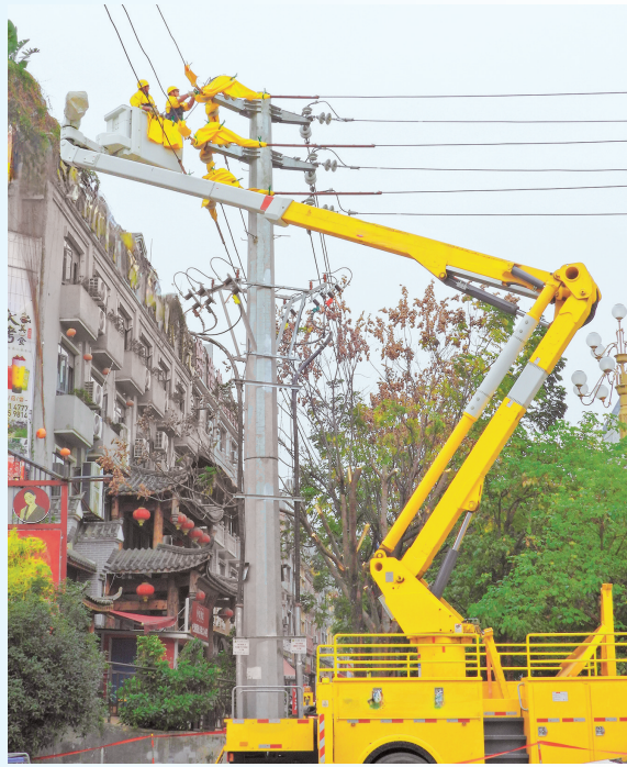
←↑实施带电作业对10千伏架空配电线路进行入地改造。 卢关文 摄
