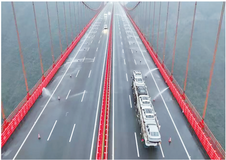
智能融雪剂喷洒系统正在喷洒融雪剂。
