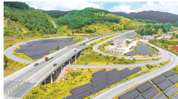
毕威高速水塘互通匝道圈打造“路衍光伏”示范场景，为零碳高速建设补充能源支点。
