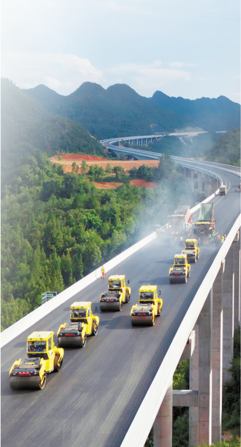
贵平高速弃渣利用路段正在进行路面施工。 何小波 摄
