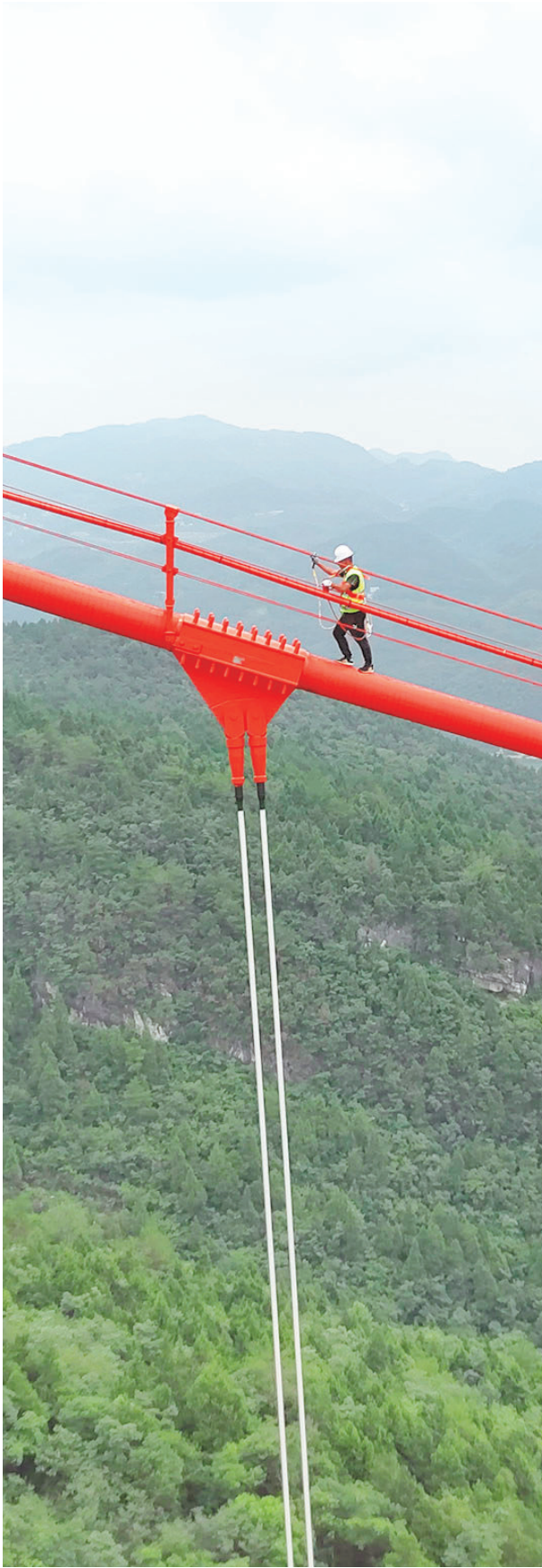
肖凯东爬上悬索桥主缆进行检测。 (受访者供图)
