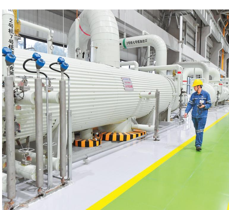
贵州织金平远清洁能源有限责任公司规划建设装机规模2070MW，其中国家电投贵州金元织金“上大压小”异地改建项目（2×660MW），采用世界首台660MW超超临界“W”火焰锅炉，锅炉效率93%，为目前同类型机组W火焰锅炉效率最高。这项技术不仅降低成本，还能减少氮氧化物排放，让燃烧更清洁。图为近日运行人员在汽机平台巡检。
