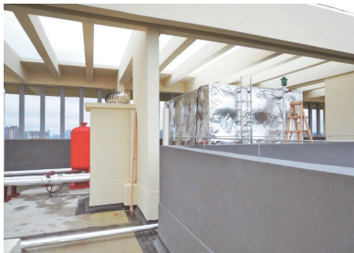
↑ 楼顶的消防水箱和涡轮增压泵，装在业主的卧室屋顶上。
