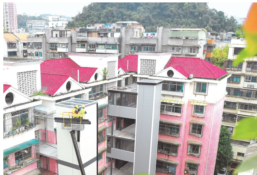
10月23日，工人正为贵阳市南明区团坡桥小区10栋加装电梯。该区围绕民生改善，采取“政府补助+居民自筹”的方式推进老旧小区加装电梯，目前已累计投入资金1000万元。赵松 摄（影像贵州）
