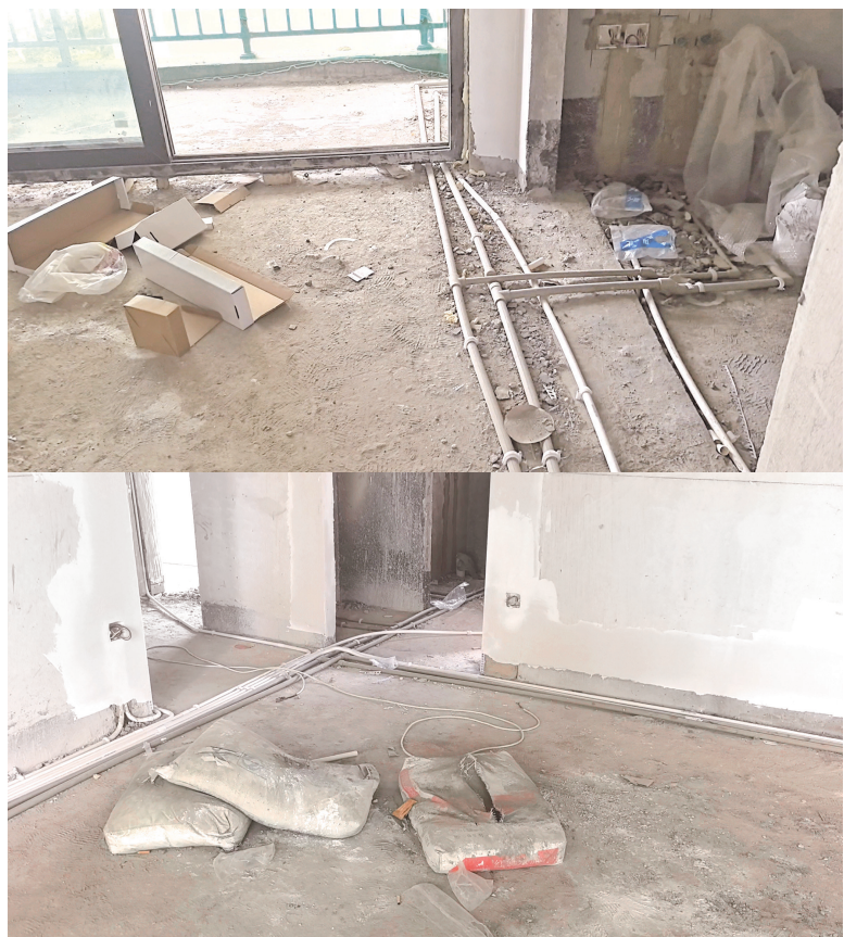
邓先生房屋现状。
