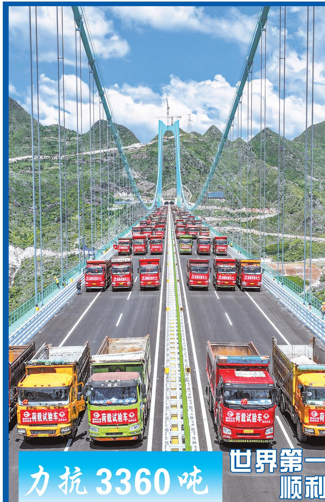
本报讯 (记者 刘力维 刘青)8月25日，经过5天紧张有序的检测，由贵州交投集团所属桥梁集团承建的世界第一高桥——花江峡谷大桥荷载试验全部顺利完成，向着9月底通车目标迈出关键一步。
