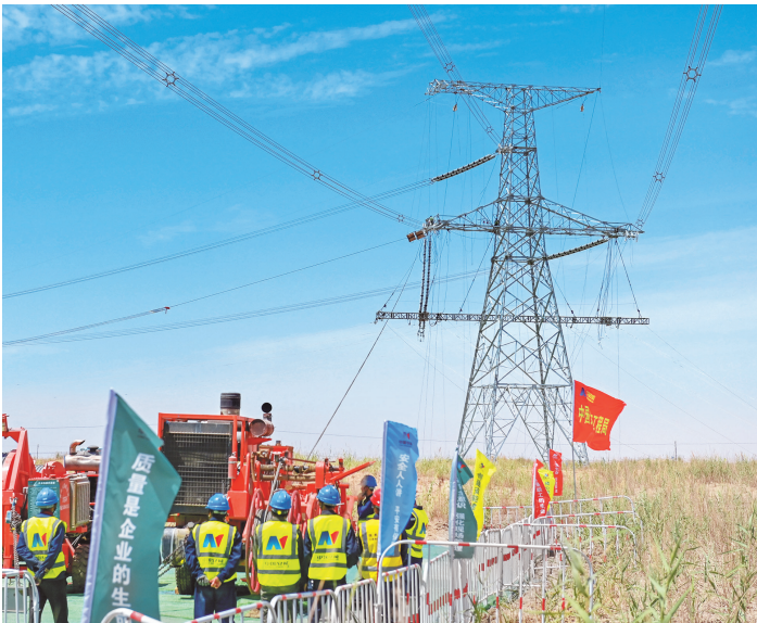
在且末-若羌750千伏线路,电力员工开展带电消缺作业。 新华社发
